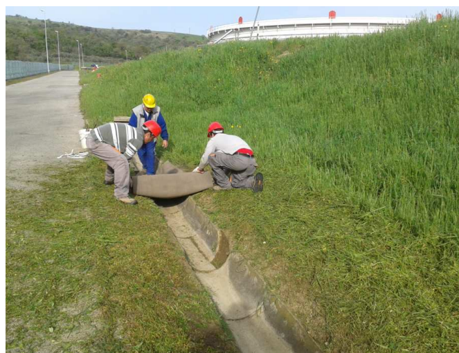
srotolamento CC5 al centro della canaletta
