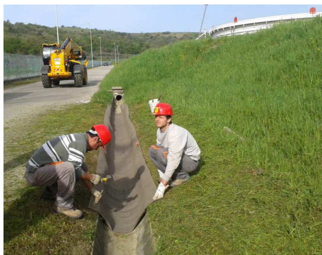
ancoraggio CC5 prima dell'idratazione
