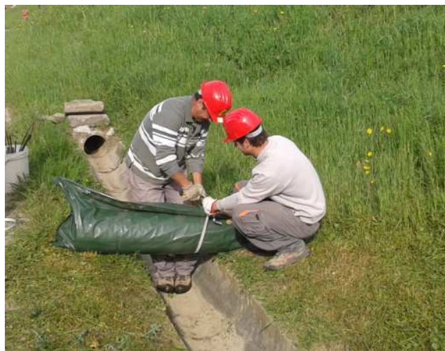
preparazione rotoli geotessuto CC5
