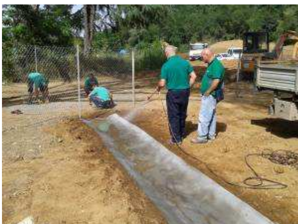
fase di idratazione
