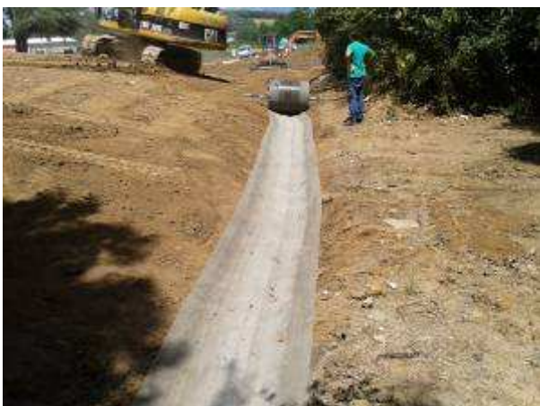
vista di cantiere
