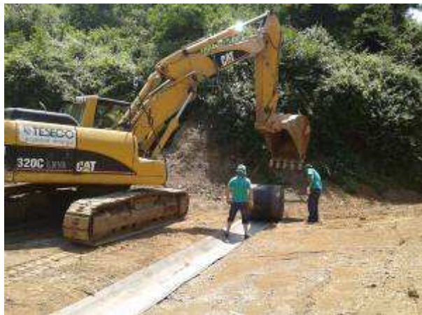
operazione di stesura geotessuto CC5
