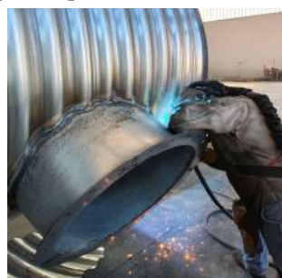
saldatura derivazione a flangia
