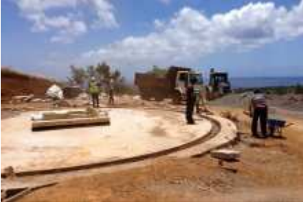
Preparazione base di appoggio
