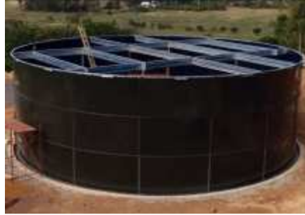
Preparazione orditura del tetto
