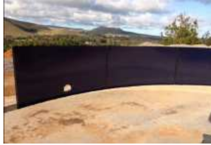
Inizio montaggio moduli
